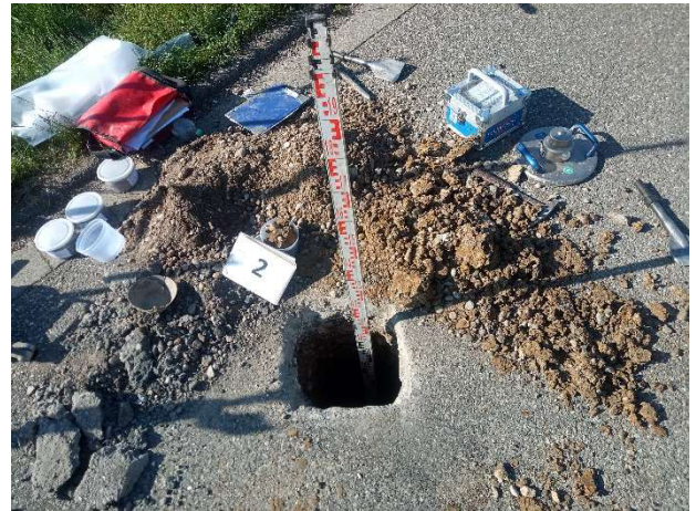
Foto 2: Handschurf und Aushub bei RKS 2
