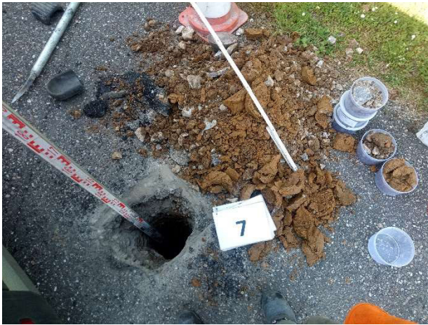
Foto 7: Handschurf und Aushub bei RKS 7
